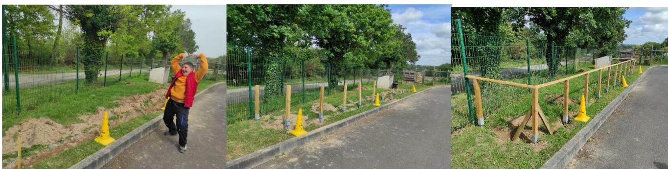
Vous pouvez voir sur les photos. Après avoir creusé la tranchée, on a mis les poteaux et installé la barrière. On a aussi laissé un trou pour mettre la porte de l'enclos.
